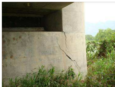
Figura 6. Puente nuevo, Río Ulua.
