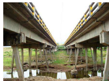
Figura 9. Puentes sin daños relevantes
