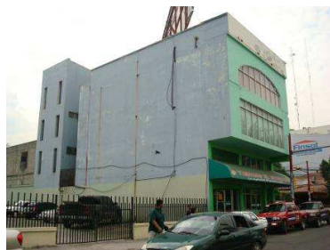
Figura 11. Edificios vulnerables a torsión
