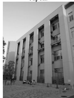
Figura 31.- Sistemas de arriostramiento instalado para aumento de capacidad sismo-resistente- Japón.
