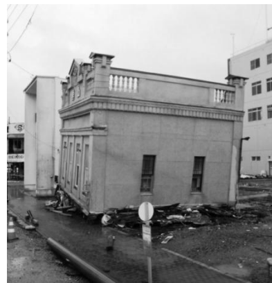
Figura 13.- Colapso por piso débil-Japón,
