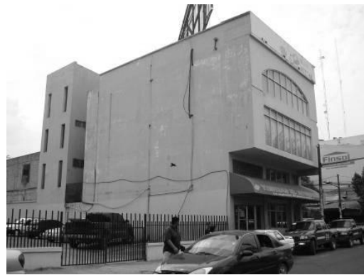
Figura 2.- Estructura irregular sin daños apreciables-Honduras. (Tomada de Carvajal, 2011)
