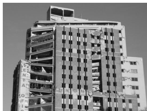
Figura 8.- Irregularidad estructural en planta y elevación-Chile.
