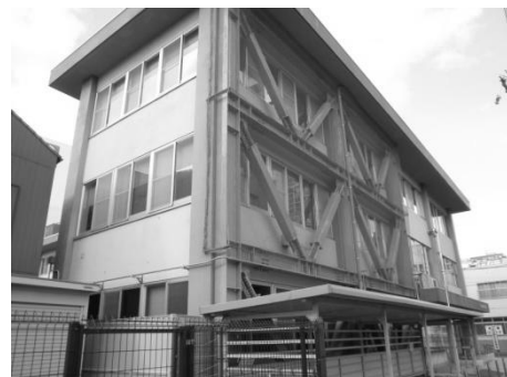
Figura 31.- Sistemas de arriostramiento instalado para aumento de capacidad sismo-resistente- Japón.
